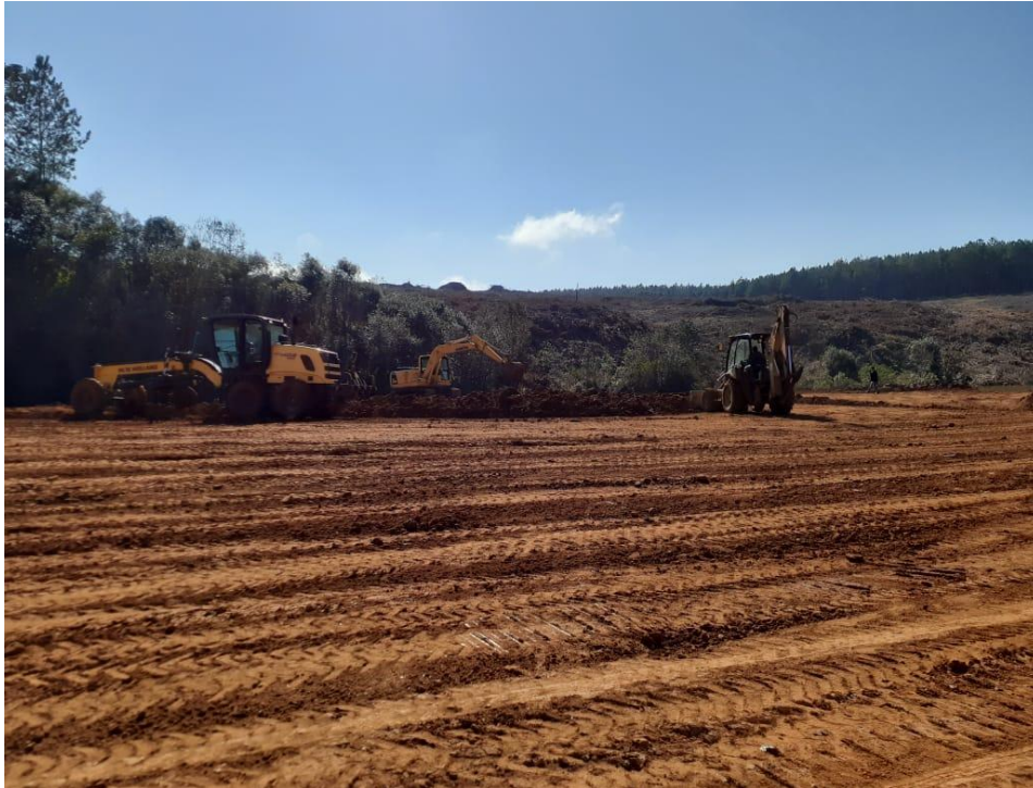
Foto 01: Aterro Construção de Vertical
