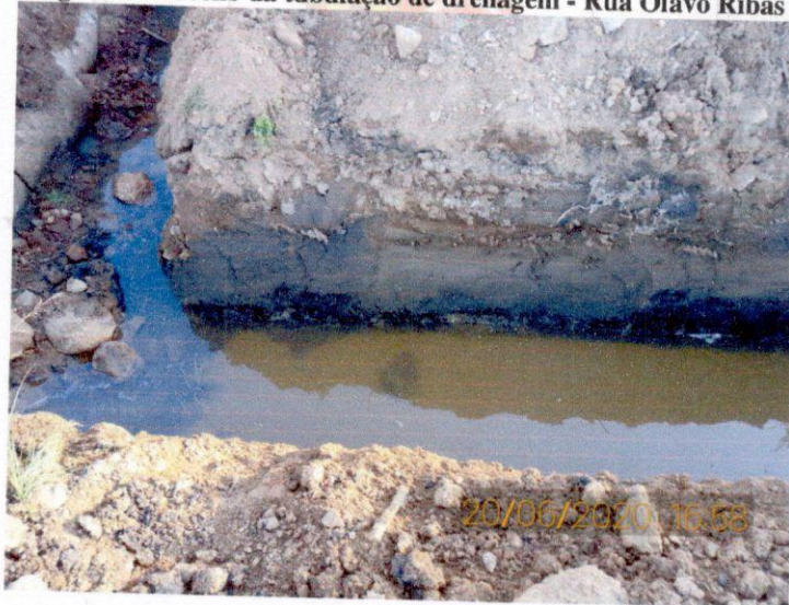
Figura 1 - Trecho da tubulação de drenagem - Rua Olavo Ribas
