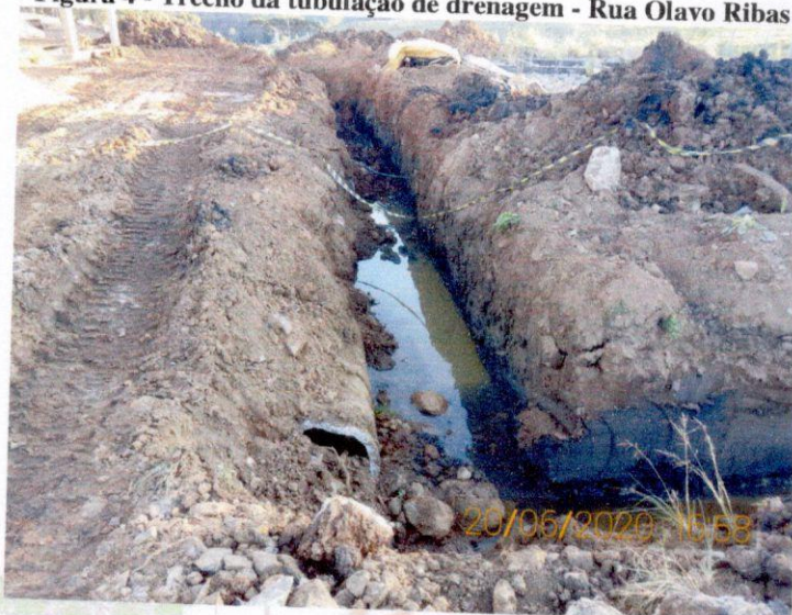
Figura 4 - Trecho da tubulação de drenagem - Rua Olavo Ribas
