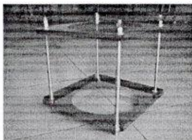
Armadura de aço para concreto da base
