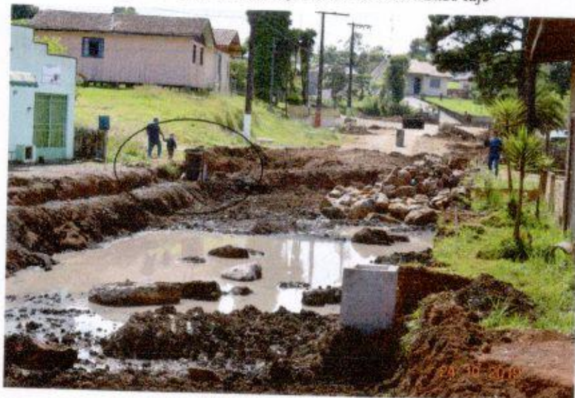
Figura 1 - Foto da escavação onde foi encontrado laje
