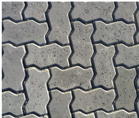
Figura 02 - Forma de assentamento dos blocos.
